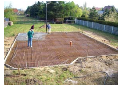
Betonieren der Bodenplatte
