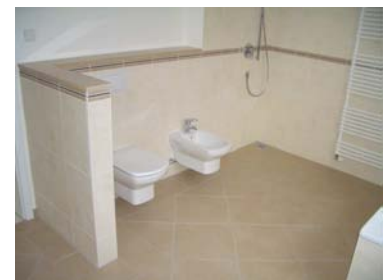
Badfliesen & bodengleicher Dusche
