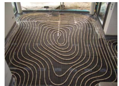
Fußbodenheizung
