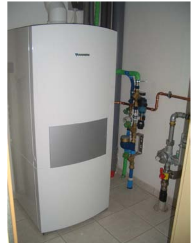
Junkers Gas-Brennwert-Therme Modul
