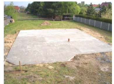
fertige Bodenplatte
