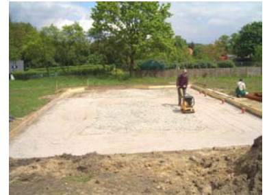
Verdichtung des RC-Materials
