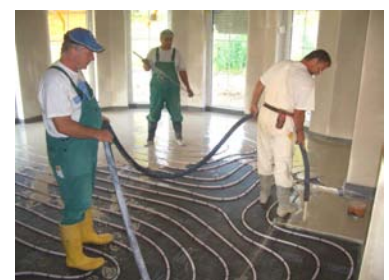
Fußbodenheizung & Anhydritestrich
