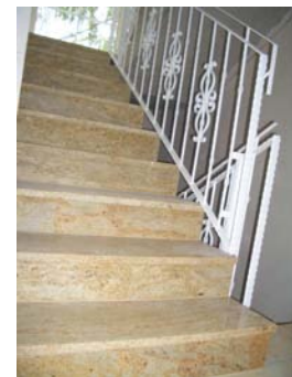
Stb.-Treppe mit Granit belegt
