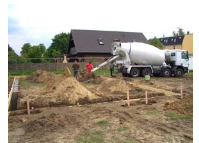
Umlaufende Streifenfundamente
