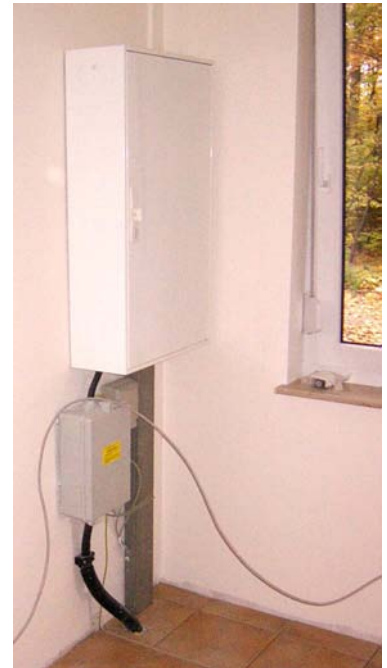
Elektro- Hausanschluss
