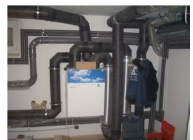
Be- & Entlüftungsanlage v. Pluggit
